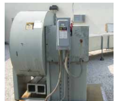
STAIR PRESSURIZATION FAN
